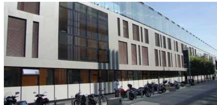
Les impostes du Campus Arc 2 permettent de ventiler le bâtiment de manière naturelle
