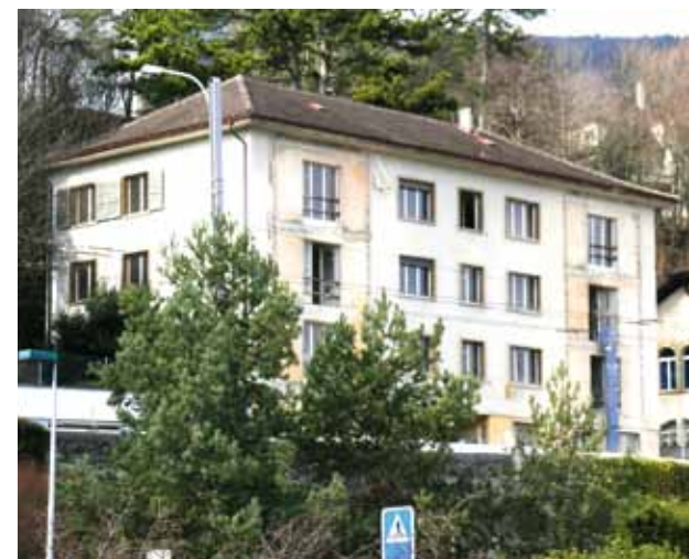
Les Saars pendant les travaux de rénovation.
