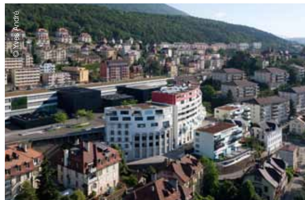
Le Campus Arc 1 et les logements du quartier Ecoparc dotés de panneaux solaires thermiques.
