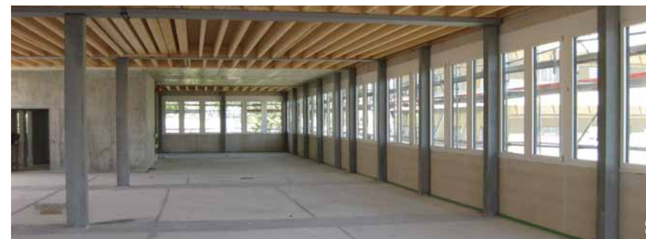
L'alliage bois-béton mis en place à Microcity.
