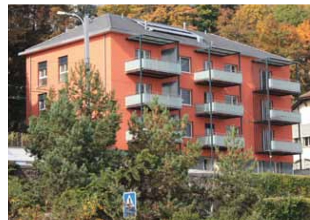
Les Saars après les travaux de rénovation.
