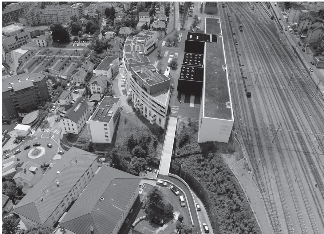
Neuenburg, Passerelle du Millénaire (Verbindung zwischen dem Mail-Hügel und dem Bahnhofplateau)
