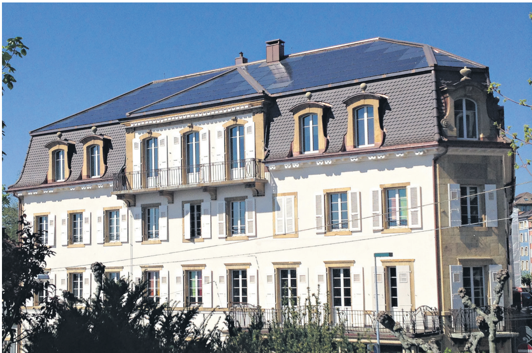
Le toit photovoltaïque de l'Hôtel des associations a été salué par le Prix solaire suisse 2015. (DR)
