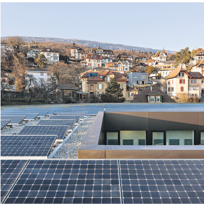
Le toit solaire de Microcity. Le bureau Bauart a profité de la topographie de la ville pour inscrire le bâtiment dans le quartier historique. (BAUART/PHOTO YVES ANDRÉ)
