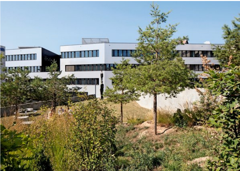
À Neuchâtel, Microcity est un bâtiment en forme de petite ville qui abrite notamment l'Institut de microtechnique de l'EPFL. Yves André
