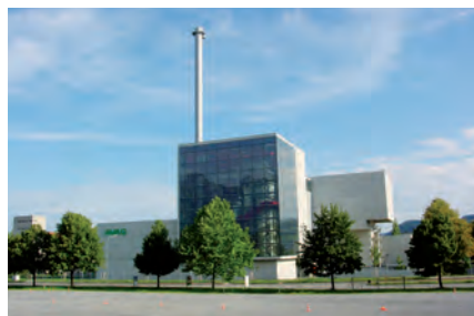
Die KVA Thun versorgt den Wirtschaftspark mit Wärmeenergie.
