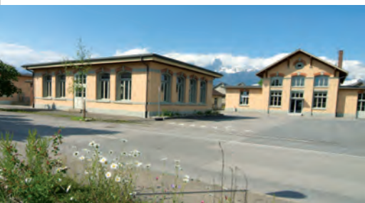
Die Uttigenstrasse verfolgt eine «differenzierte» Arealentwicklung und Aussenraumgestaltung.
