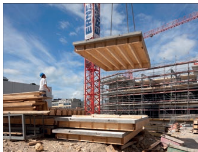
Microcity, montage sur le chantier des éléments de dalles préfabriqués en bois-béton. PHOTO YVES ANDRÉ
