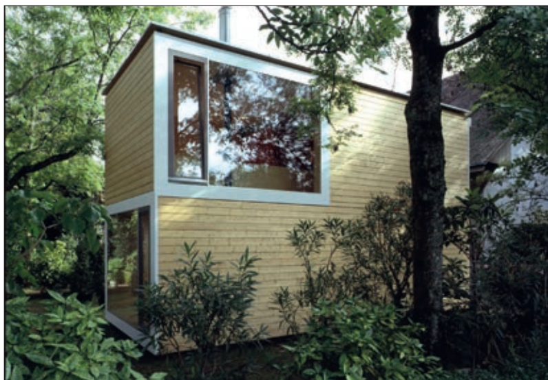
La maison Option (ou Smallhouse) a été développée par Bauart notamment pour densifier des secteurs de maisons individuelles.
