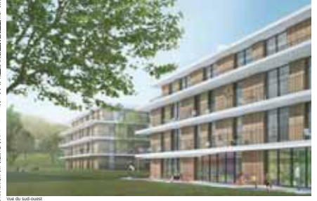
Vue du sud-ouest
